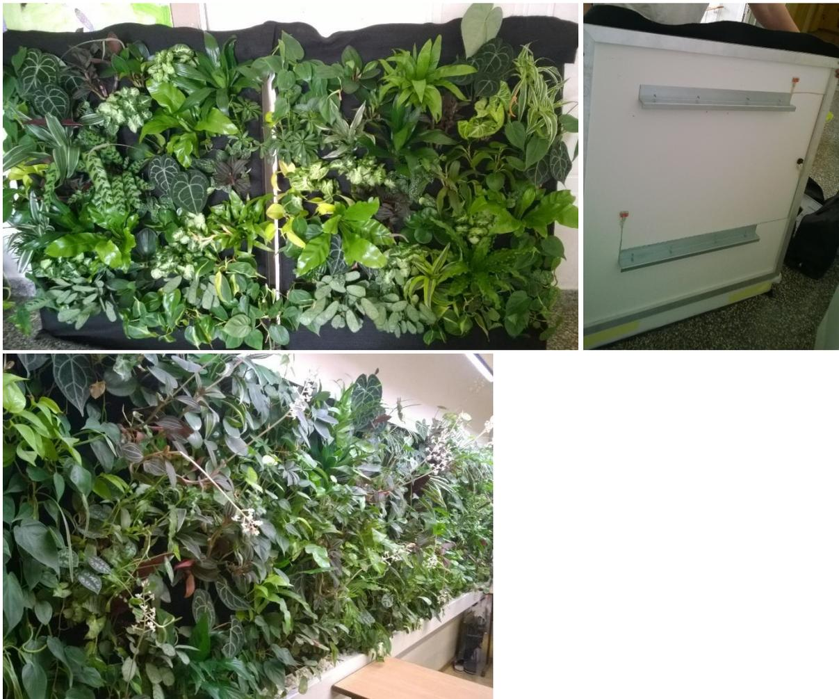
*Abbildung 2: Installation des Vliessystems. Die Kunststoffplatten wurden fertig geliefert (Rechts) und mittels Schienen an die Wand gehängt (Mitte). Das Fertige System ist rechts ersichtlich.*
