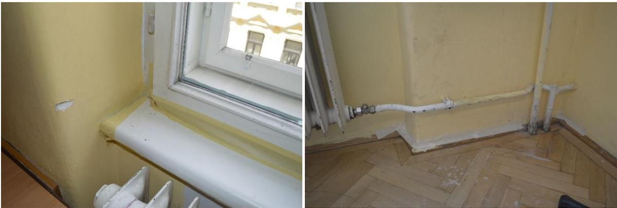
Abbildung 13: Abgeklebte Fugen, Kanten und Öffnungen zur Umgebungs- und Außenluft.
