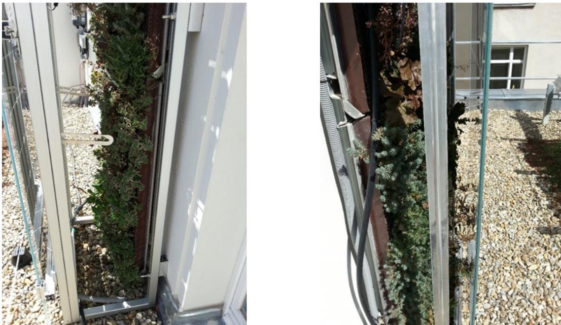
Abbildung 72: Links: Klappbare Unterkonstruktion; Rechts: Fixe Unterkonstruktion
