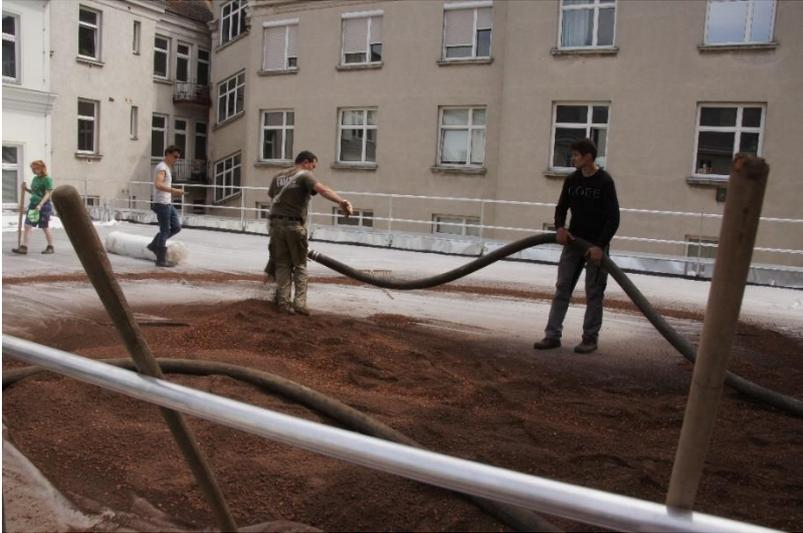
Abbildung 6: Drainageelemente mit Filtervlies und Einblasen des Dachbegrünungssubstrates.
