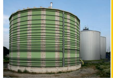
eine erhöhte Säurebeständigkeit auf und widersteht chemischen Angriffen wesentlich besser als das bisher verwendete Material. Das Aufbringen einer Beschichtung im Inneren des Behälters ist nicht mehr notwendig, was zu einer weiteren Material- und Kostenersparnis führt.
