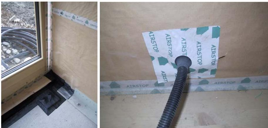
Abbildung 33: Kontrolle der Luftdichtheit am Bau
