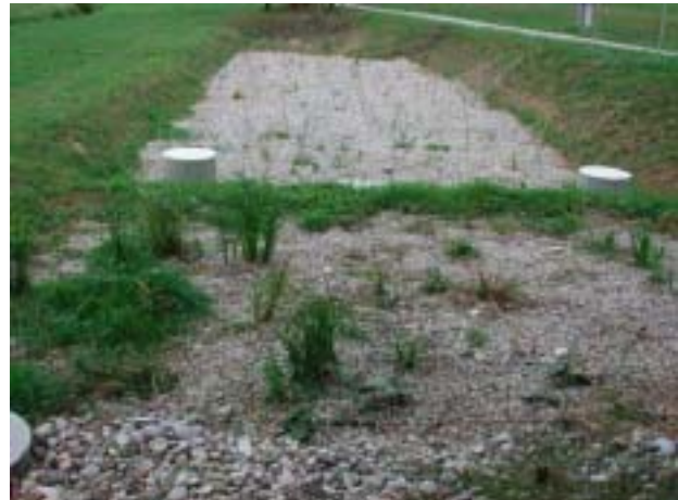
Abbildung 11: Fischverarbeitung Goricar - Pflanzenkläranlage
