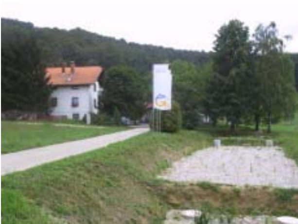
Abbildung 11: Fischverarbeitung Goricar - Pflanzenkläranlage
