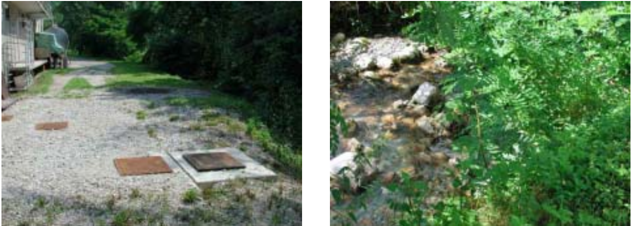
Abbildung 13: Mechanische Vorreinigung und Einleitung in den Vorfluter
