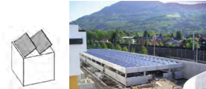
Abbildung 10: Schemazeichnung und Beispiel von Solarkollektoren auf Flachdach
