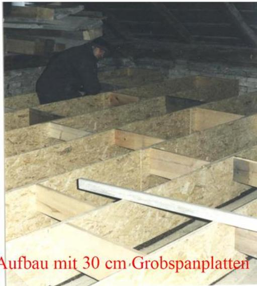
Aufbau mit 30 cm Grobspanplatten
