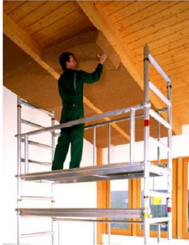
Der Einbau erfolgt mit ca. 1% Übermaß, so dass der Dämmstoff im Gefach klemmt.
