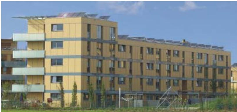
Abbildung 26: Solarunterstützte Wärmeversorgung über ein 2-Leiter-Netz mit Wohnungsstationen im Salzburger Wohnbau „Stiegelgründe“ (Bildquelle: Sonnenkraft, Kärnten).
