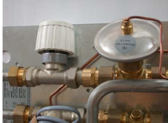
Abbildung 33: Differenzdruckregler (rechts) und Rücklauftemperaturbegrenzer (links) im Raumwärmeversorgungskreis von Wohnungsstationen (Beispielhaft für das Produkt der Firma Redan), (Bildquelle: AEE INTEC)
