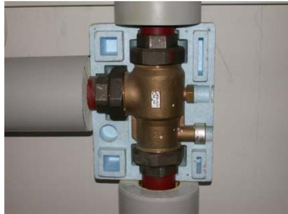
Abbildung 36: Beimischeinrichtung mit Fixtemperatur-einstellung ohne Fremdenergie. (Bildquelle: AEE INTEC)
