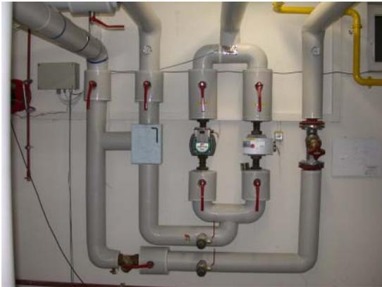
Abbildung 35: Parallele Anordnung der Pumpen für die Winterlast (links) und die Sommerlast (rechts) inkl. Beimischeinrichtung (hellblaue Armaturendämmung). (Bildquelle: AEE INTEC)
