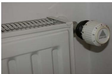
Abbildung 34: Die Raumtemperaturregelung erfolgt über Thermostatventile (Bildquelle: AEE INTEC)
