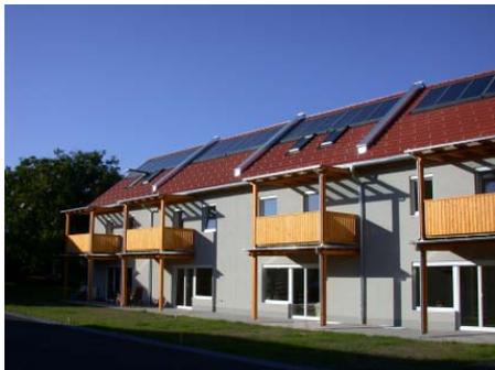
Abbildung 38: Wärmeversorgung über ein 2-Leiter-Netz mit dezentralen Brauchwarmwasserspeichern in einem steirischen Reihenhausbau (Bildquelle: AEE INTEC).
