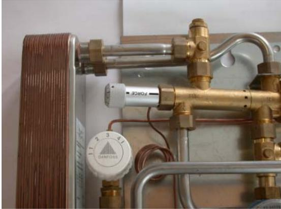
Abbildung 32: Komponenten der Brauchwassererwärmung: Plattenwärmetauscher, einstellbarer Proportionalregler sowie Zirkulationsbrücke mit Rücklauftemperaturbegrenzer (Beispielhaft für das Produkt der Firma Redan), (Bildquelle: AEE INTEC)
