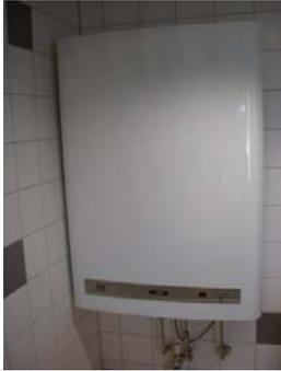
Abbildung 39: Über ein 2-Leiter-Netz geladener dezentraler Brauchwarmwasserspeicher. Volumen und Anordnung unterscheiden sich im Vergleich zu konventionellen Nachtstromspeichern nicht (Bildquelle: AEE INTEC).
