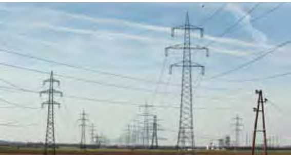
Foto: Klima- und Energiefonds/Ringhofer
