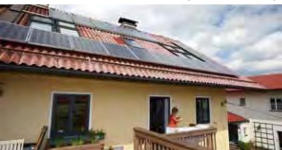
Foto: Klima- und Energiefonds/Ringhofer
