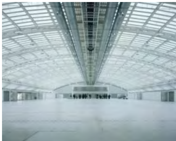
Abb. 7: Optimierte Tageslichtnutzung durch Sonnenschutzraster im Design-Center Linz (Foto: Bartenbach)
