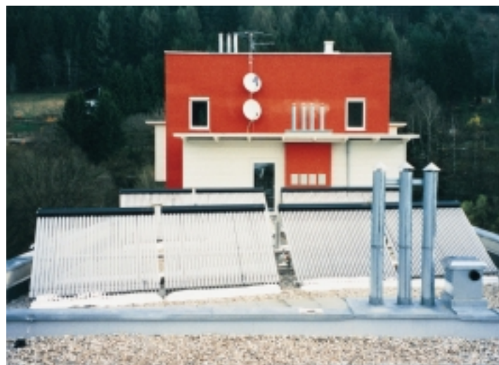
Abb. 7: Vakuum-Röhrenkollektor
