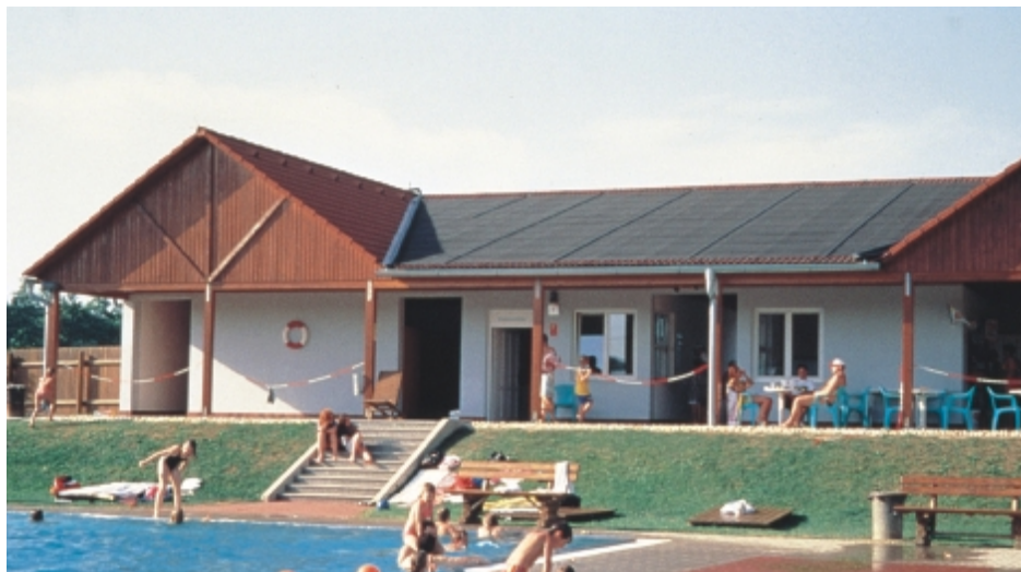
Abb. 14a: Mit Sonnenenergie zu höheren Beckentemperaturen im Freibad
