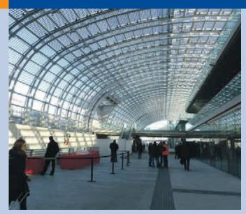
Fig. 2 - BIPV plant in Torino, 553 kWp, monocrystalline modules (Photo: ENERGYGLASS, <u>www.energyglass.eu</u>; Information: GSE Gestore dei Servizi Energetici - Atlasole <u>www.gse.it</u>).
