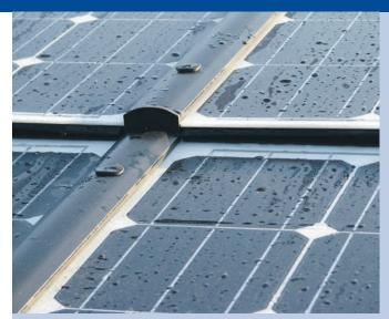
Fig. 1 - Detail of BIPV monocrystalline modules in the 5 kWp PV plant in Verona (Photo: GSE Gestore dei Servizi Energetici - <u>www.gse.it</u>).
