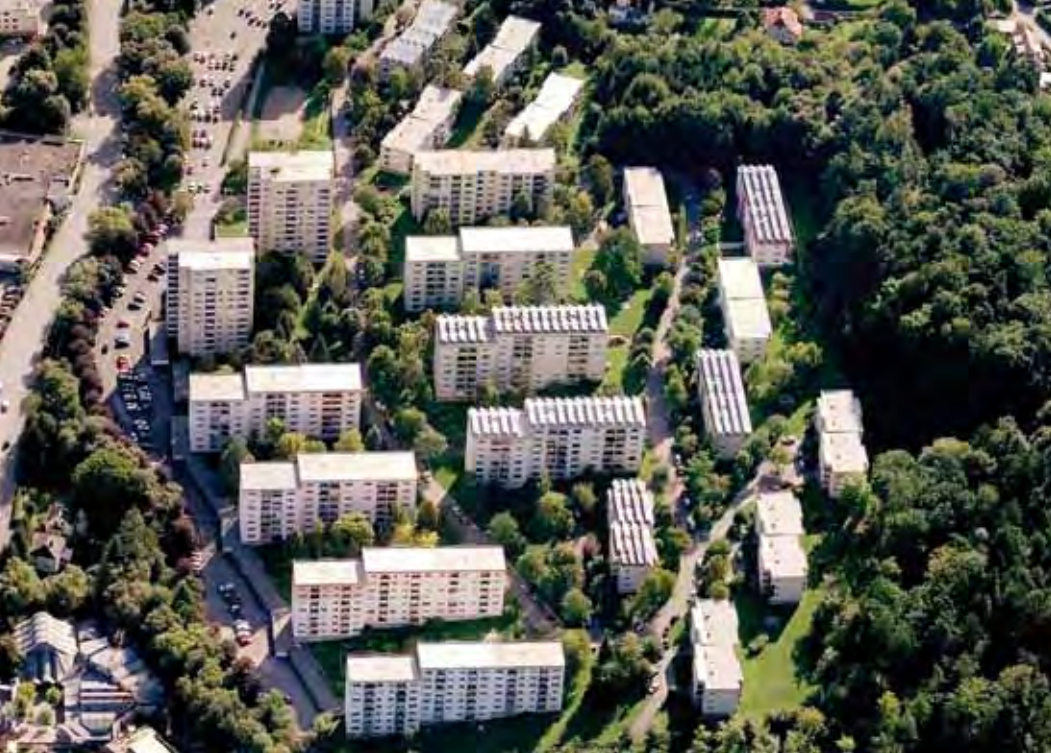
◀ Abbildung 1 Solargestütztes Nahwärmenetz Graz-Berlinerring
