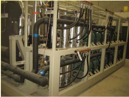
Multi-Kompressor Hochdruck- Wärmepumpe mit CO 2 als Arbeitsmittel (Hersteller: Advansor)
