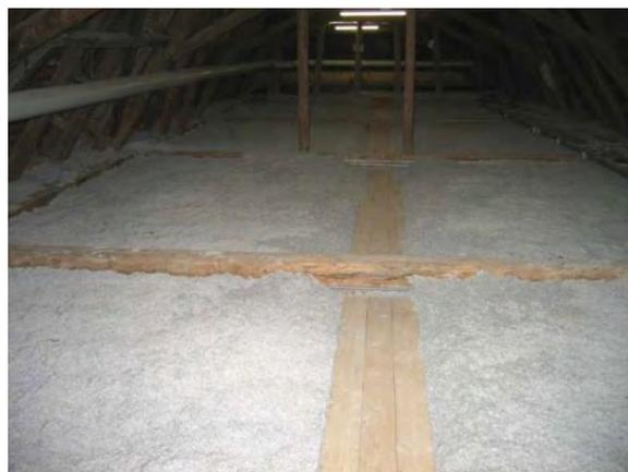
Abbildung 22 - Isolierung der obersten Geschosdecke mit eingeblassener Zellulose
