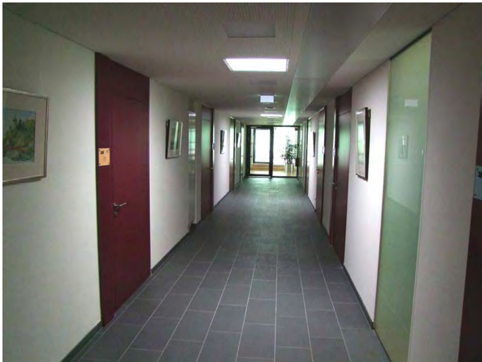
Abbildung 19: Gangbereich [Beleuchtung ausgeschaltet] (Foto: Grazer Energieagentur GmbH)
