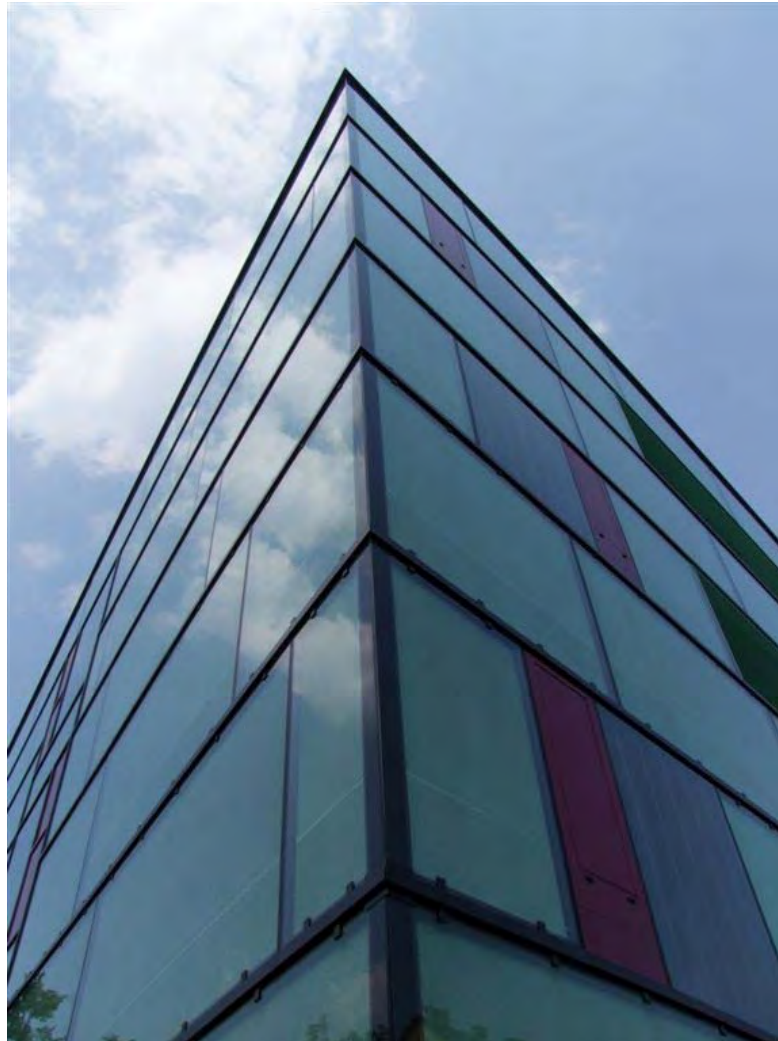
Abbildung 12: Bauteil Bezirksgericht, fertige Fassade mit Solarwaben (Bildquelle: Grazer Energieagentur GmbH)
