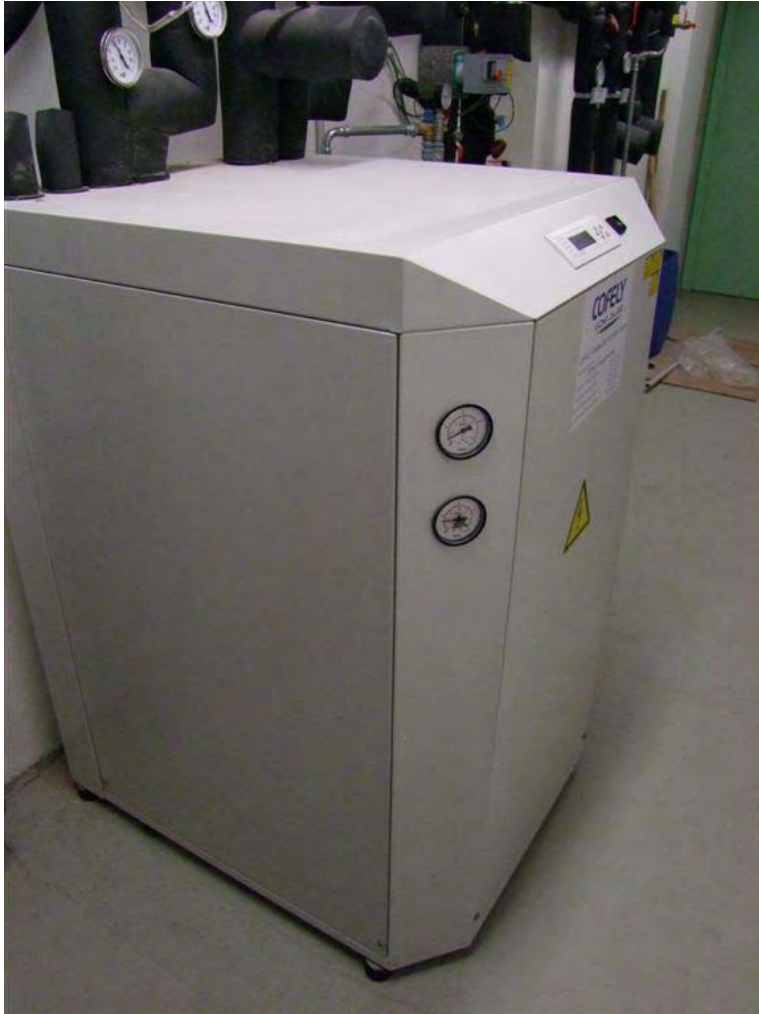
Abbildung 25: Die im Einsatz befindliche drehzahlgeregelte bivalente Wärmepumpe (Typ Frigopol DSRBWHP30); Bildquelle: Grazer Energieagentur)
