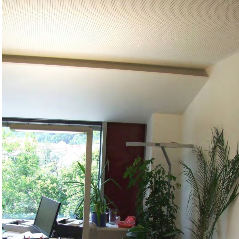
Abbildung 20: Lichtlenkendes Deckenelement (Foto: Grazer Energieagentur GmbH)
