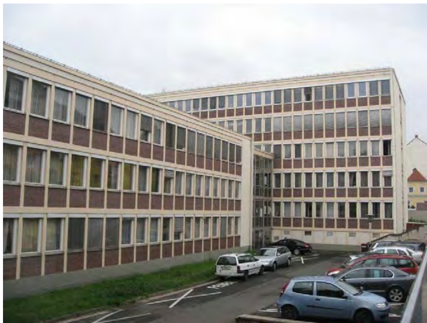
Abbildung 9: Bestand vor Sanierung Amtshaus Bruck/Mur (Quelle: e7 Energie Markt Analyse GmbH)
