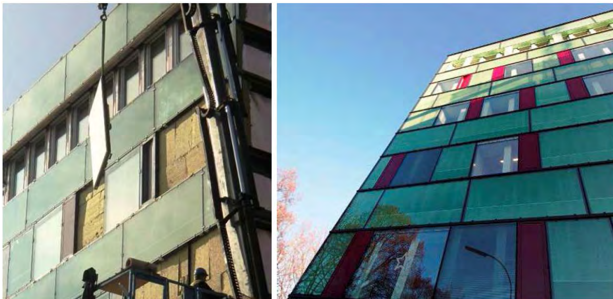
Abbildung 14: Links: Montage der Paneele (Quelle: gap-solution); Rechts die fertige Fassade
