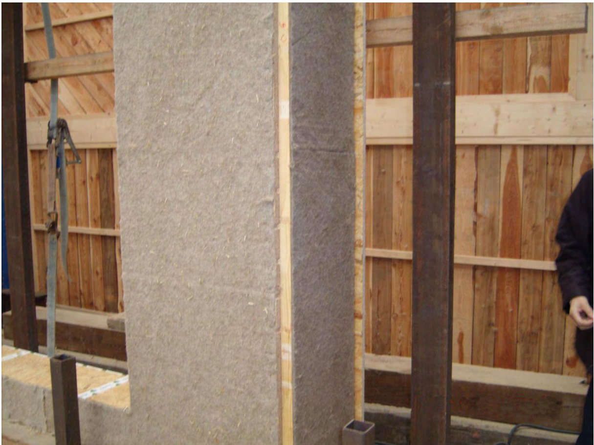
(Foto 4: Lopas-Wandelement bei Befüllung)
