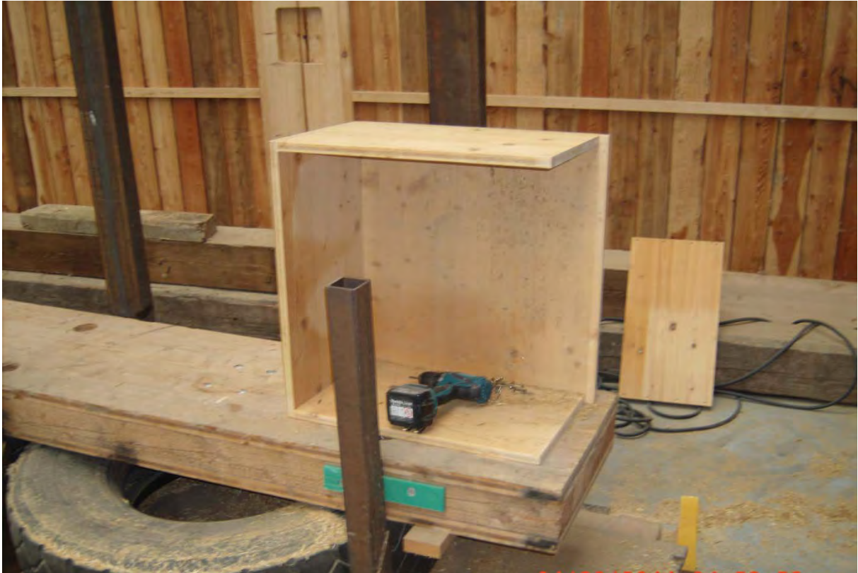
(Foto 5: Prüfkörper wird als Kleinmodell gebaut. Darunter die provisorische Rüttel-Plattform zur Befüllung der Wandelemente, mit Reifen unterlegt.)
