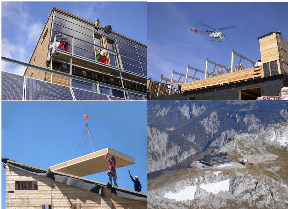
Abbildung 3: Außenansichten Alpiner Stützpunkt Schiestlhaus [DI Wilhelm Hofbauer]
