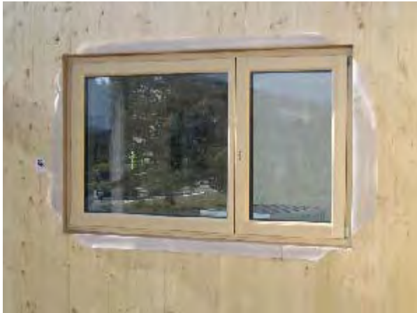
Werkseitig montierte passivhaustaugliche Fenster mit strömungsdichter Anbindung Quelle: Bauaufsicht BAI, 14.02.2006
