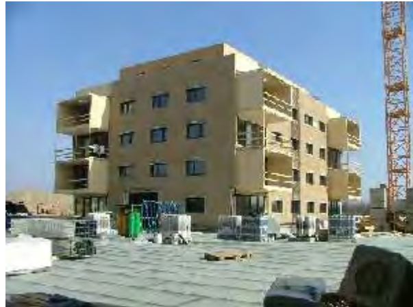
Abgeschlossene Montage der Holzbaufertigteile Quelle: Bauaufsicht BAI, 24.03.2006
