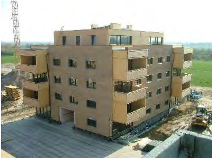
Abbildung 8: Haus C nach abgeschlossener Holzfertigteilmontage (Quelle: Bauaufsicht BAI)
