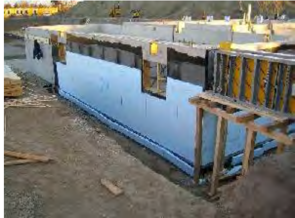
Dichten und Dämmen der Kellerwände
