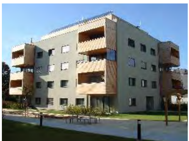
Fertiggestellte Anlage Quelle: AEE INTEC
