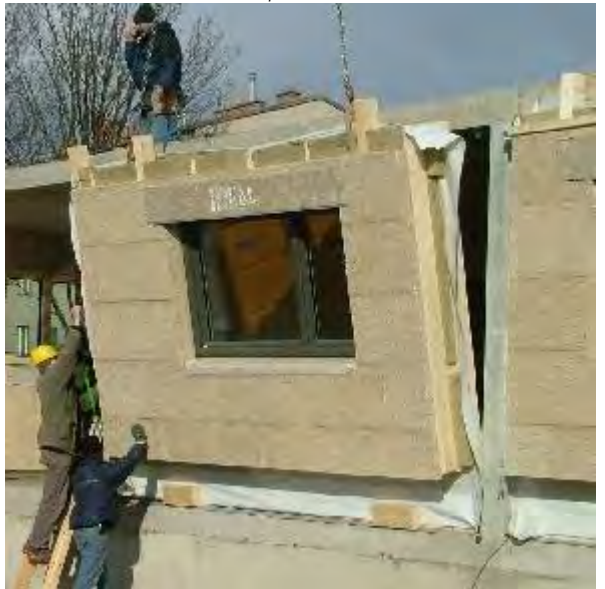
In Position gehobene Elemente
