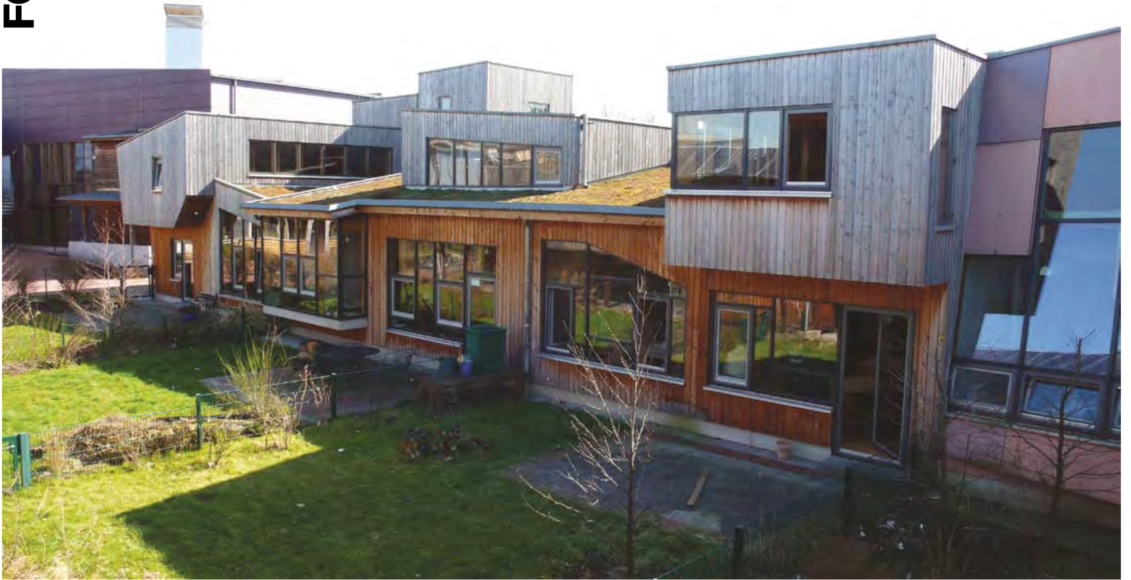
Die Lernhäuser der Evangelischen Gesamtschule Gelsenkirchen, errichtet 1998 bis 2004 von Peter Hübner, plus+ Bauplanung, zusammen mit den Schülern. Foto: Robert Temel
