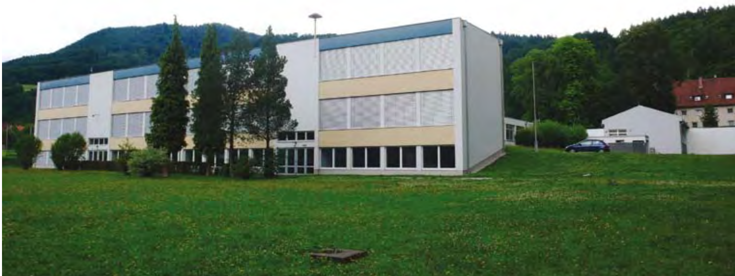
Sanierungsinitiative Gemeinde Kapfenberg (Stmk) – thermische Sanierung der Schule Redfeld bei gleichzeitig sensiblem Umgang mit der Architektur Ferdinand Schusters: Sanierung unter der Federführung von DI Sabine Christian, Bereichsleitung Raumplanung Gemeinde Kapfenberg. Fotos: ????????????????
