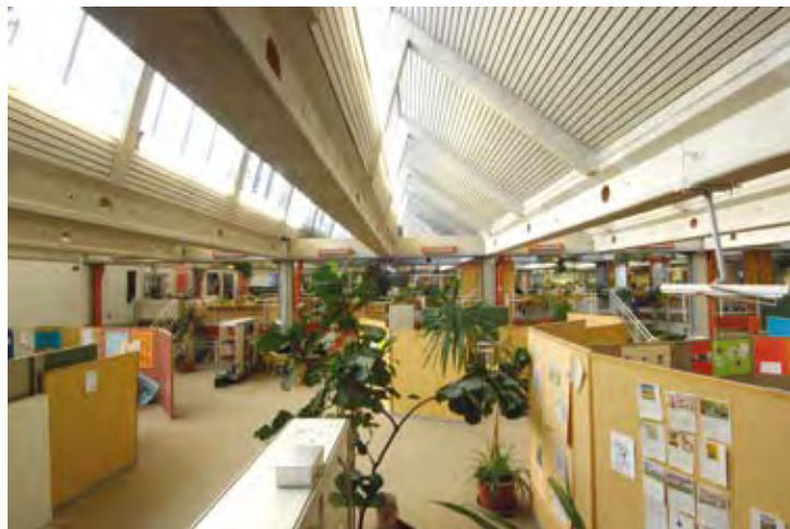
Futurum-Schule: Die satteldachförmigen Aufbauten sind ehemalige Lichthöfe, die im Zuge des Umbaus mit Glas überdacht wurden. Foto: Hans Ahlenius, Futurum
