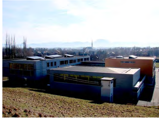
Nord-Ost-Ansicht Hauptschule II, Turnsaal, Polytechnische Schule Quelle: AEE Intec
