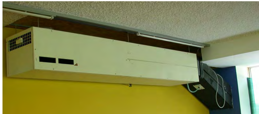
Abbildung 15 Fassadenintegrierte Luftkanalführung (links); aeroschool Kompaktgerät, erste Version noch nicht umgebaut (rechts); [AEE Intec]
