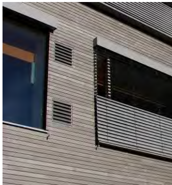
Abbildung 15 Fassadenintegrierte Luftkanalführung (links); aeroschool Kompaktgerät, erste Version noch nicht umgebaut (rechts); [AEE Intec]
