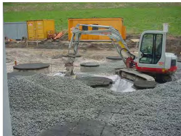
Abbildung 4 Brunnengründungen Schulsanierung Schwanenstadt [H. Plöderl et al.]
