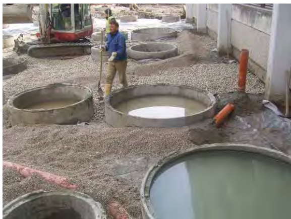
Abbildung 4 Brunnengründungen Schulsanierung Schwanenstadt [H. Plöderl et al.]
