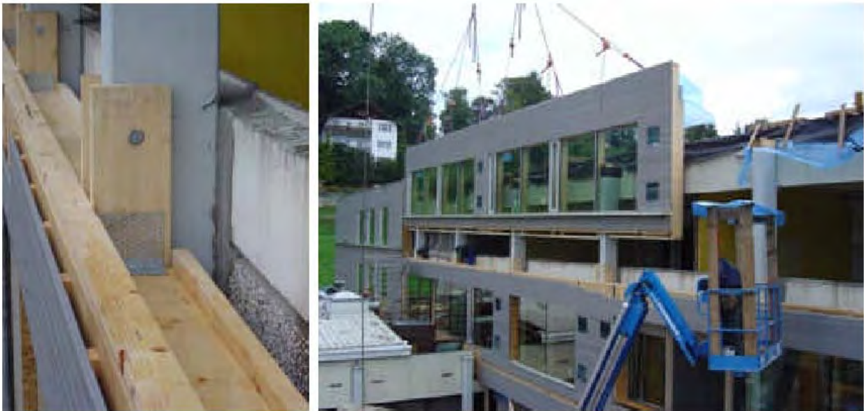
Abbildung 7 Montage der vorgefertigten Holzwandelemente in Passivhausqualität [PAUAT Architekten]
