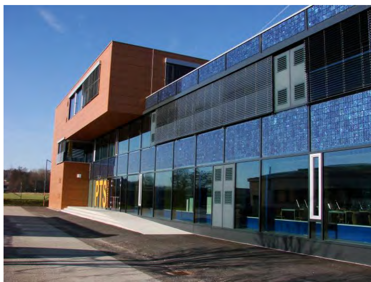
Abbildung 12 Südfassade, Eingang mit Photovoltaikfassade [AEE INTEC]
