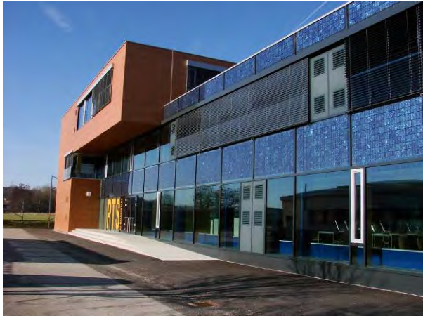
Eingangsbereich mit Photovoltaikfassade Quelle: AEE Intec
