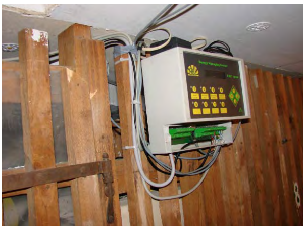
Datenlogger und Modem Quelle: AEE INTEC
