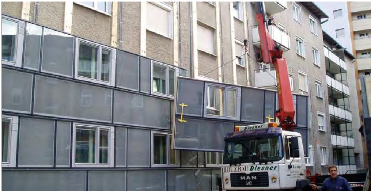
Abbildung 2 Montage der vorgefertigten Fassadenelemente [architekturpreis]
