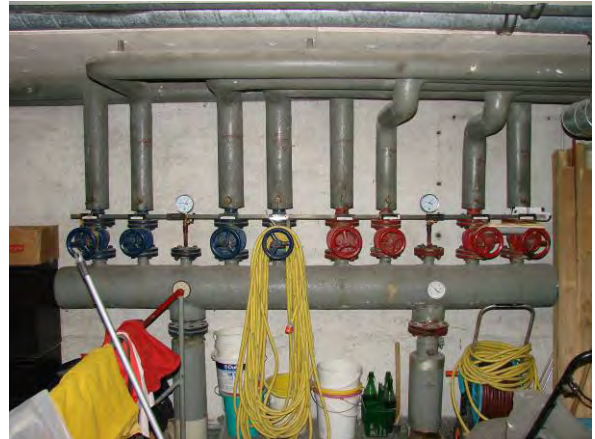
Hausverteilung Fernwärme Quelle: AEE INTEC
