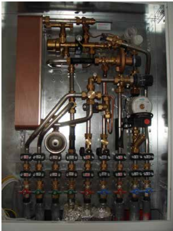
Abb. 2: Heizungsübergabestation
