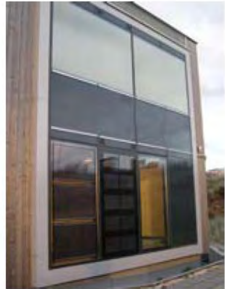
Abbildung 19: Transparenter solarthermischer Kollektor (links), (Quelle: ISE, Deutschland)
