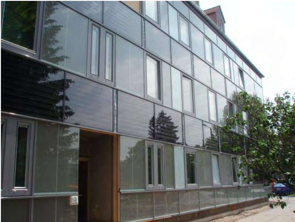
Abbildung 17: Hochwertige Sanierung mit vorgefertigten Fassadenelementen, welche die thermischen Kollektoren integriert haben. Graz, Dieselweg. Bauherr: GIWOG
