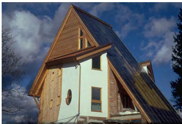
Abbildung 16: 100% solar beheiztes Einfamilienhaus Nader in der Nähe von Graz. Installierte Leistung 60 \text{ kW}_{\text{th}} ( 85 \text{ m}^2 Kollektorfläche) und ein 75 \text{ m}^3 Wärmespeicher.
