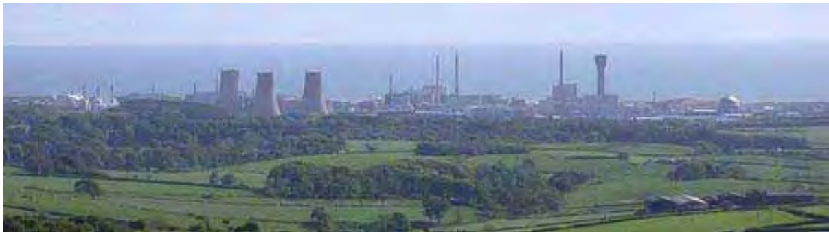
Abbildung: Panorama-Aufnahme der kerntechnischen Anlage bei Sellafield
