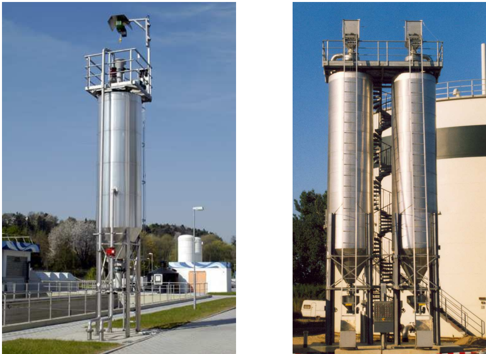
Abbildung 55: Entschwefelungsanlagen an Masse mittels Eisenpellets, links: Kläranlage Bad Vilbel, rechts: Kläranlage Leipzig-Rosental [Muche 2004]
