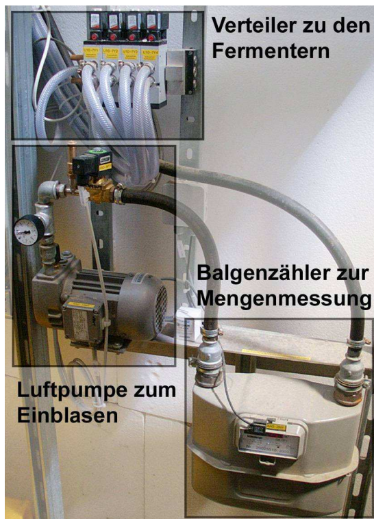
Abbildung 46: Komponenten für eine In Situ Entschwefelung (Quelle: Dieter Moor)
