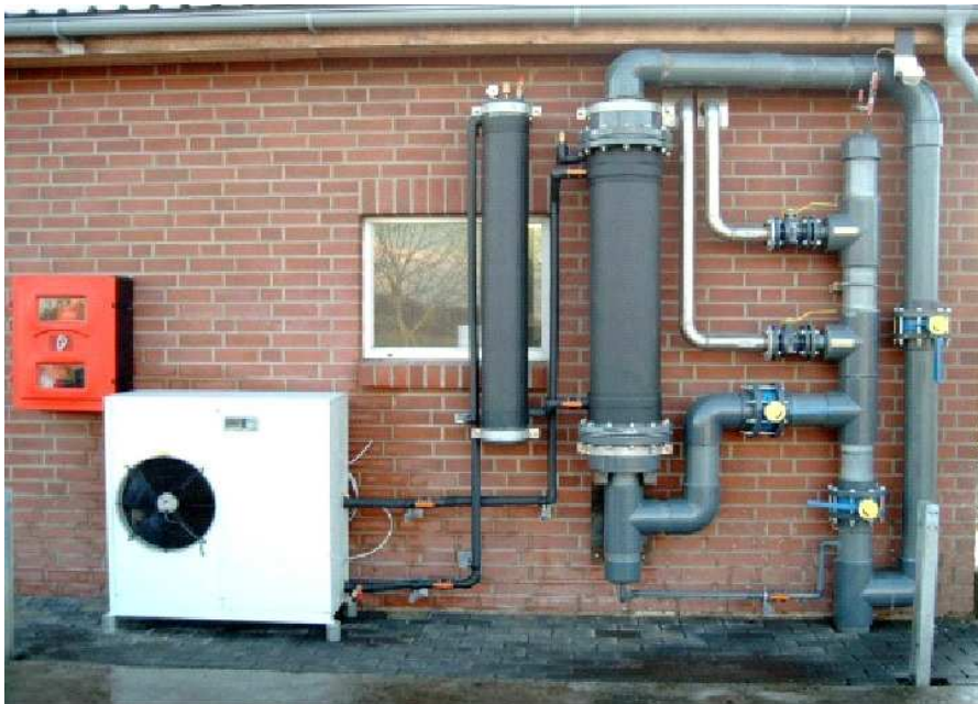
Abbildung 59: Beispiel einer Anlage zur Trocknung von Biogas durch Gaskühlung [www.biogas-entfeuchtung.de]
