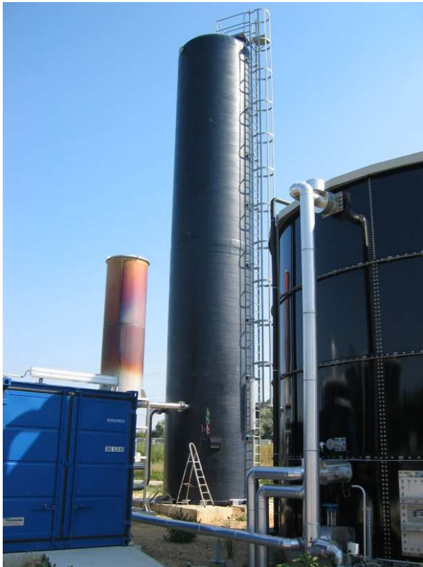
Abbildung 48: Externe biologische Entschwefelung bei der Biogasanlage Bruck/Leitha NÖ Durchsatz von 700m 3 /h (Quelle: Dieter Moor)
