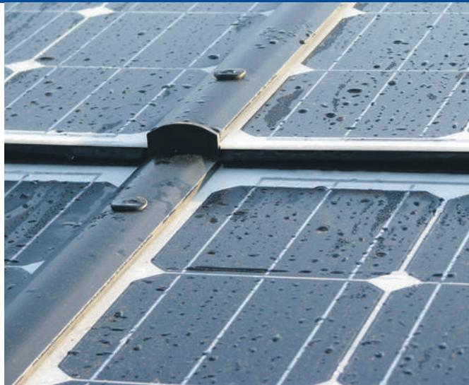
Fig. 1 - Detail of BIPV monocrystalline modules in the 5 kWp PV plant in Verona (Photo: GSE Gestore dei Servizi Energetici - [www.gse.it](http://www.gse.it)).
