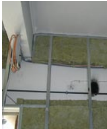
Mineralwolle zweilagig zwischen Ständerkonstruktion
