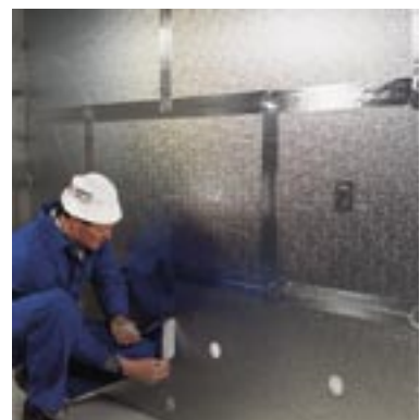
Versetzte Anordnung und vollflächige Verklebung alukaschierte Polyurethan-Hartschaumplatten
