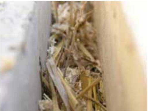
Der Anschluss zum Installationsschacht ist wärmebrückenfrei mit Stroh ausgestopft.
