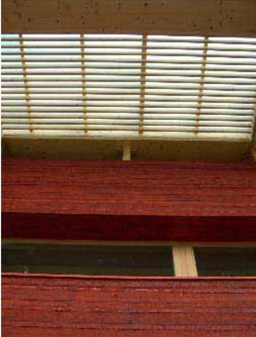
Die Außenfassade des S-HOUSE wurde mit einer eigens entwickelten Lasur behandelt. Sie basiert auf nachwachsenden Rohstoffen kombiniert mit mineralischen Pigmenten.
