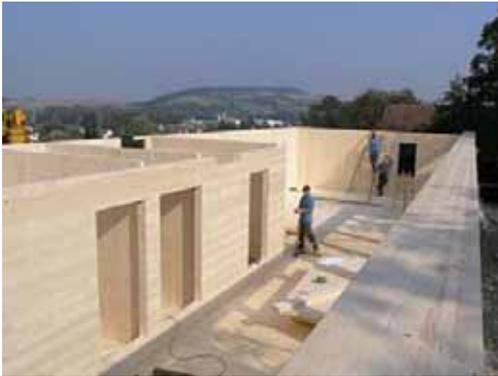
Vorgefertigte Holzelemente ermöglichen weitestgehend metallfreie Anschlüsse
