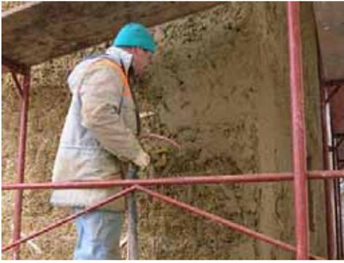
Der Lehmputz wird maschinell direkt auf die Strohballe gespritzt, die raue Strohballeoberfläche bietet dafür einen geeigneten Untergrund.
