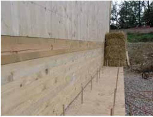
Die Strohballen werden mit Holzdübel in der auskragenden Bodenplatte fixiert
