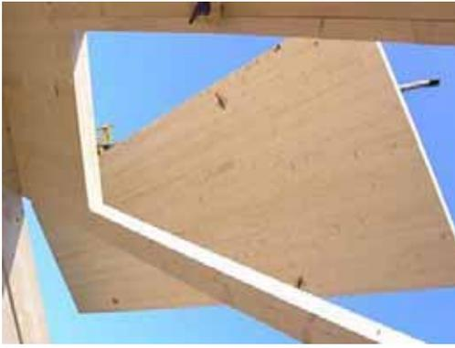
Nach Fertigstellung des Erdgeschosses wird die massive Deckenplatte einjustiert.
