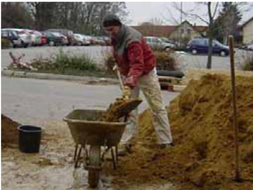
Das gesiebte Aushubmaterial wird vor Ort mit Sand abgemagert und mit Wasser aufbereitet.
