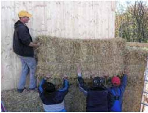
Jede neue Strohballebene wird auf die Holzstangen in den Strohbällen darunter gesteckt und so gegen seitliches Verrutschen fixiert.
