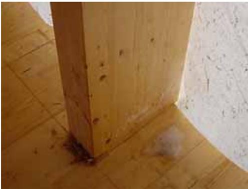
Die Stützsäulen an der südseitigen Glasfassade sind ebenfalls in Holzkonstruktion ohne metallische Verbindungselemente ausgeführt.
