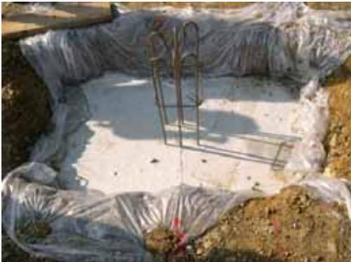
Jedes einzelne Punktfundament ist zur Erleichterung der späteren Entfernung und Entsorgung mit einer dünnen Folie eingepackt. Die Stahlbewehrung dient zur späteren Aufnahme der Gebäudelasten.
