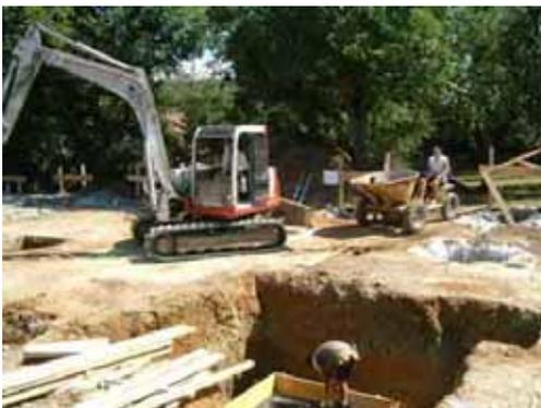
Aushub der Punktfundamente und des Installationsschachts. Das anfallende Erdmaterial, gut von der Humusschicht getrennt und damit frei von organischen Einschlüssen, wird später noch benötigt. Nach Aushub des zentral unter dem S-HOUSE situierten Installationsschachts wird dessen Schalung errichtet
