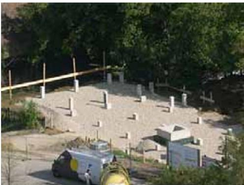
Eine leicht entfernbare Rollierung ersetzt die ansonsten übliche Versiegelung der Fläche
