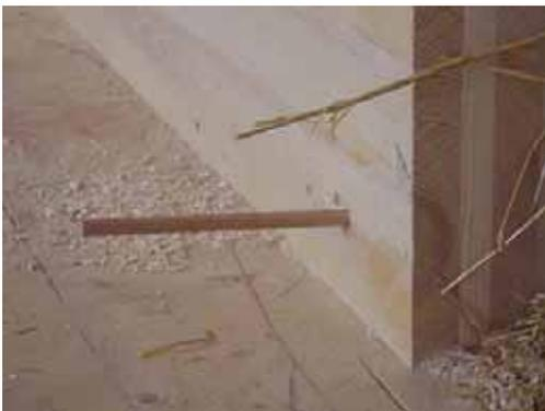
Holz-Holzverbindungen mit Dübeln aus Buchenholz ermöglichen eine metallfreie Wandkonstruktion.
