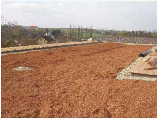
Die Dachoberfläche ist begrünt ausgeführt und schützt die Kautschukfolie vor UV-Strahlung. Regenwasserretention und positive Auswirkung auf das Mikroklima, sowie die Wiederherstellung einer Grünfläche im gleichen Ausmaß der verbauten Fläche, sind wichtige Aspekte dieser Lösung.
