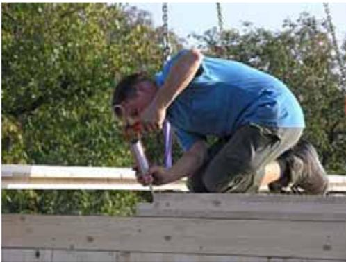
Die Deckenelemente werden zu einer luftdichten Konstruktion zusammengesetzt.
