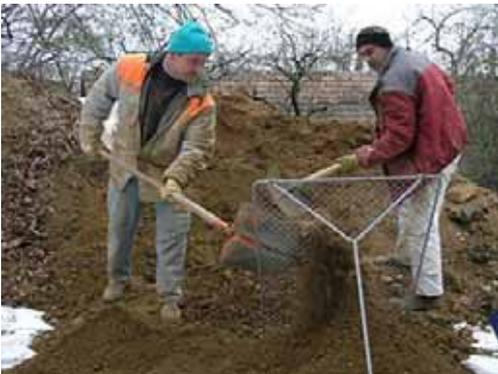
Der Lehmputz wird direkt vor Ort gewonnen, indem das Aushubmaterial der Punktfundamente und des Installationsschachts aufbereitet wird.
