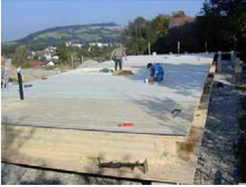
Über passivhaustaugliche Anschlussdetails werden die Bodenplatten zusammengefügt. Der Bodenaufbau ist nun fertiggestellt.
