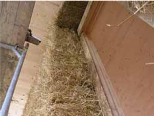
Die Strohballen bieten eine strukturierte, ebene Oberfläche, die sich optimal als Putzuntergrund eignet für die Aufbringung einer Lehmschicht als Alternative zu den sonst üblichen Winddichtigkeits Folien.
