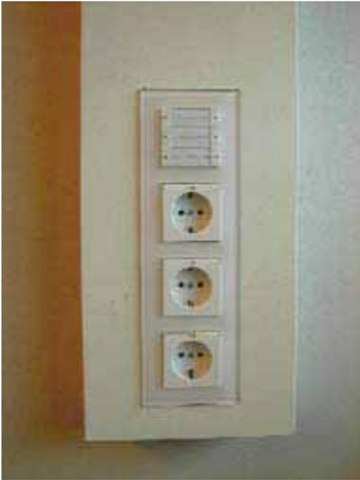
Über den Steckdosen befindet sich die Steuerung für die Beleuchtung, welche manuell aber auch durch eine Automatik (Bewegungs- und Helligkeitssensor) gesteuert werden kann.
