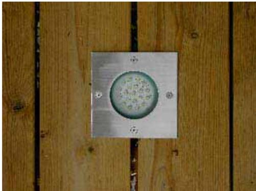
Die Außenbeleuchtung wird teilweise mittels Leuchtdioden bewerkstelligt die eine durchschnittliche Lebensdauer von 100.000 Stunden haben und 80% weniger Energie verbrauchen als konventionelle Glühbirnen.
