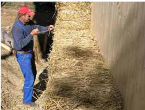
Die Strohballen werden mit den vorher angebrachten Hanfschnüren an die KLH-Massivholzplatten gespannt.
