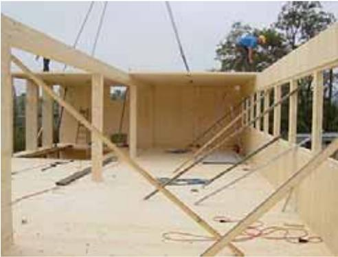
Das Obergeschoss wird luftdicht aufgesetzt, ohne Folien/Schäume aus fossilen Rohstoffen zu verwenden.
