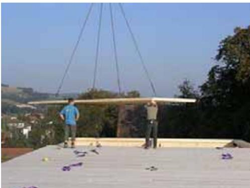
Mit Montage der letzten Deckenplatte ist die passivhaustaugliche KLH-Hülle fertiggestellt.
