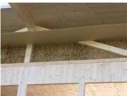
Die Belüftungsebene zwischen der wärmegeämmten Decke und dem Dach hat zum einen wärmedämmtechnische Gründe und zum anderen erlaubt diese Konstruktion große Dachüberstände. Dies ist sowohl für die sommerliche Beschattung als auch für den konstruktiven Holzschutz wesentlich.
