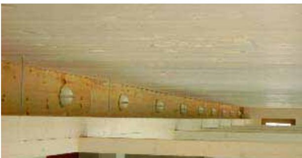
Die Kanäle liegen auf den Kabeltrassen, die ebenfalls in Holz ausgeführt sind.
