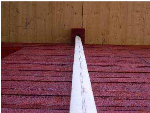
Die Ableitung des Wassers erfolgt mittels Feuerwehrschräuchen. Ein „Abfall-produkt“ wird hier sinnvoll weiterverwendet und ein Austrag von Schwermetallen in das Grundwasser vermieden, wie es bei verzinkten Regenwasserrinnen der Fall ist.
