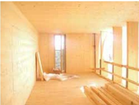
Die tragende Zwischenwand im OG ermöglicht die Realisierung eines großen Ausstellungsraumes ohne Stützen im EG
