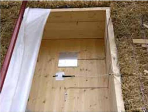
In der Strohdämmebene sind Testboxen für alternative Dämmstoffe integriert. Verwendet wurden Kork (Corktherm Dämmkork von Qualitätsbaustoffe Bucher), Flachs (Herflax von Heraklith) Hanf (Thermo Hanf von Hock) und Cellulose.
