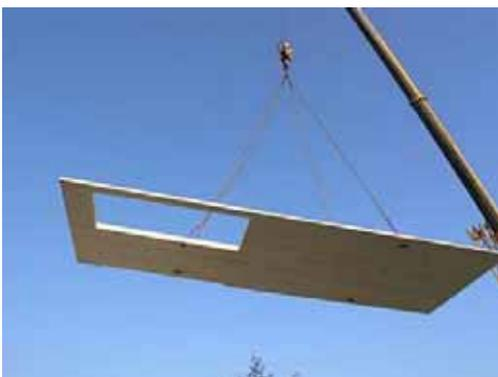
Die gesamte Massivholz-Plattenkonstruktion ist in metallfreier Ausführung realisiert.
