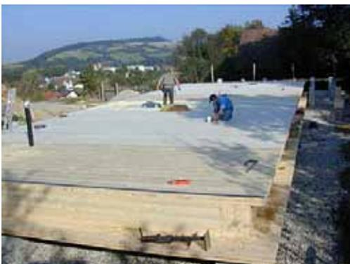
Das obere Bodenelement wird wärmebrückenfrei direkt auf die Strohdämmung gelegt.
