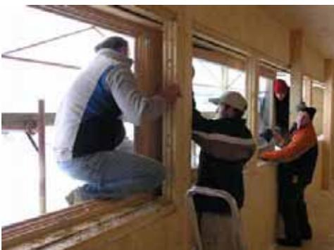
Die Anschlüsse Fensterrahmen und Wandkonstruktion werden luftdicht ausgeführt.
