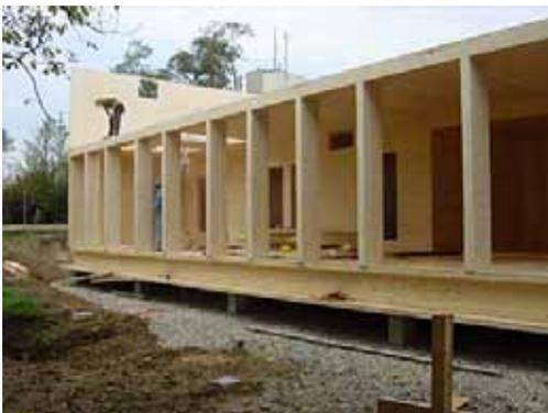
Die Wandelemente des Obergeschosses werden mit der Zwischendecke verbunden.
