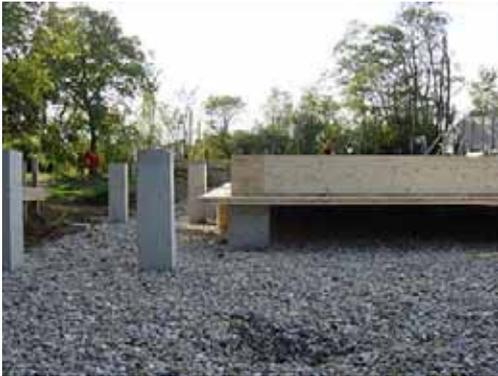
Die unterlüftete Bodenkonstruktion unterstützt den Abfluss der Kaltluft.
