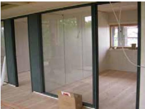
Die Zwischenwände sind mit einem einfachen Klippmechanismus fixiert und können bei Bedarf versetzt und so geänderten Nutzungsanforderungen angepasst werden.
