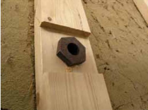
Detailansicht einer verschraubten Längslatte als Unterkonstruktion für die Fassade verwendet wird. Es besteht kein Kontakt zum Innern des Gebäudes damit sind Wärmebrücken ausgeschlossen.
