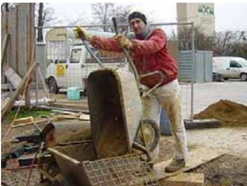
Die fertige Materialmischung kann nun in eine Putzmaschine eingefüllt werden.
