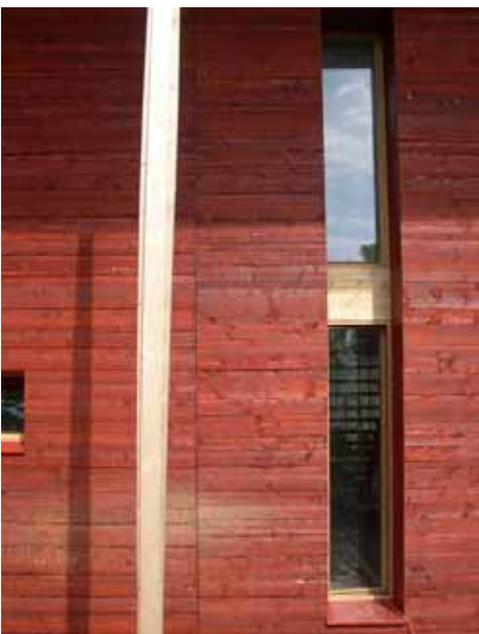
Geneigte Pendelstützen für die Dachkonstruktion sorgen für die Aufnahme seitlicher Windkräfte bei geringem Materialverbrauch.
