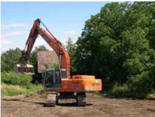
Die sorgfältige Lagerung des lehmigen Aushubmaterials ist wichtig, da der Lehm später als Putz auf die Strohballen verwendet wird. Daher auch die gewissenhafte Trennung von der Humusschicht
