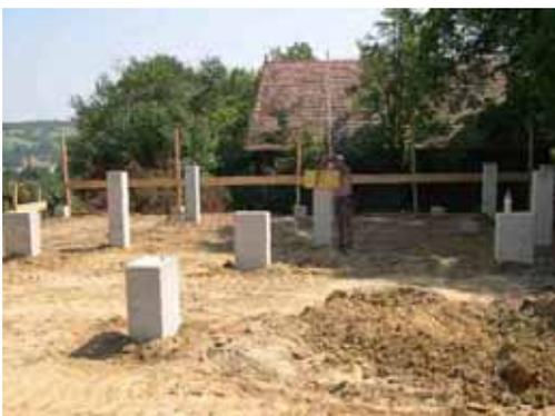
Die fertigen Punktfundamente wurden mit einem Minimum an Betonverbrauch errichtet und sind nun bereit für das S-HOUSE eine tragende Rolle zu übernehmen
