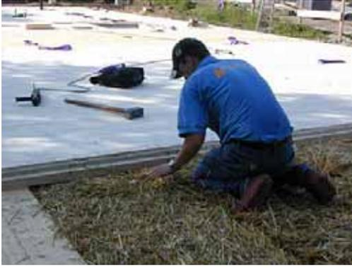
Die Strohballen müssen vor ihrem Einbau auf Feuchtigkeit überprüft werden. Beim Einbau dürfen zwischen den Ballen keine Hohlräume entstehen. Durch genaues aneinander setzen der Ballen und nachträgliches, sorgfältiges Ausstopfen mit losem Stroh, kann dies vermieden werden.
