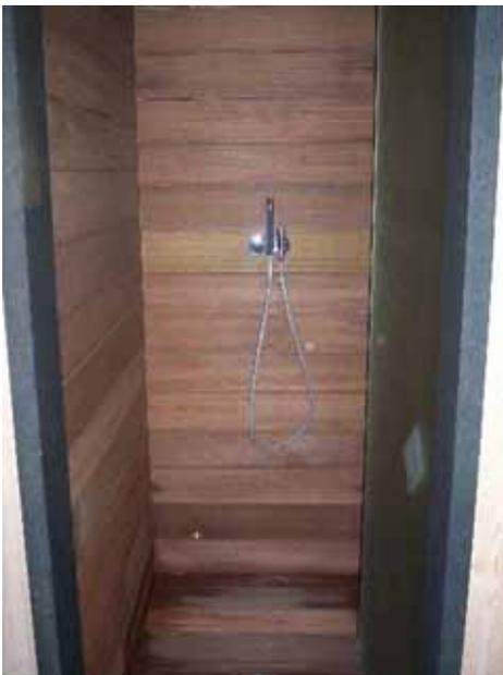
Fertiggestellter Dushraum. Die Verkleidung besteht aus wasserbeständigem Thermoholz.
