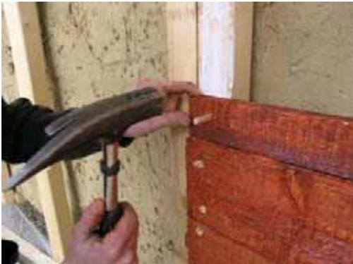
Die Fassade aus sägerauen Fichtenbrettern werden an der Längslattung mittels Leim und Holzdübeln fixiert. Damit kommt der gesamte Wandaufbau ohne metallische Verbindungselemente aus.
