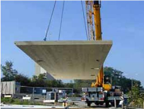
Versetzen der oberen Bodenplatte als Abschluss des Sandwich- Bodenaufbaus.
