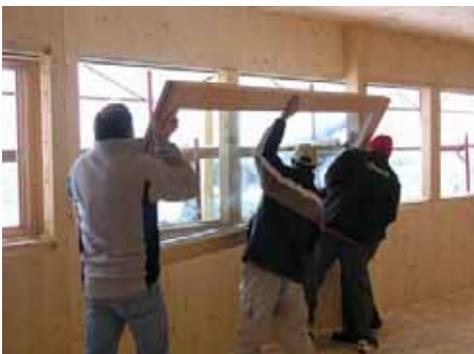
Einbau der Fenster im Obergeschoß der Nordseite. Der Rahmen besteht aus Lärchenholz.
