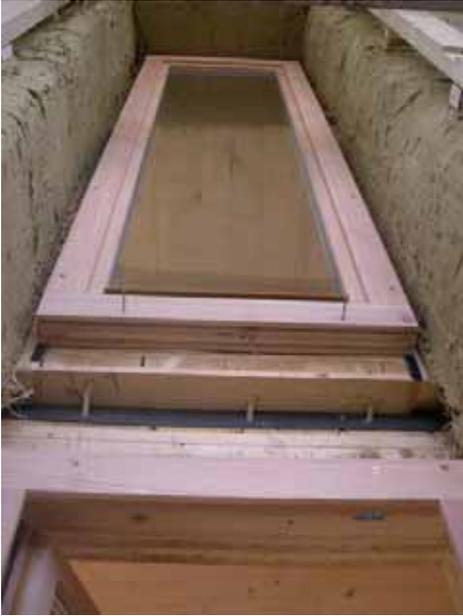
Die Fenster werden, auf dem mit Holzdübeln an der KLH-Wand befestigten Rahmen, luftdicht montiert. Die Fugen werden mit Flachs abgedichtet.
