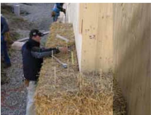
In Strohballen gesteckte Holzstangen verbinden zwei Strohballenlagen miteinander und verhindern so ein seitliches Verrutschen.
