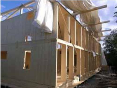
Während der Fertigstellung der Dachkonstruktion, wird eine temporäre Witterungs-Schutzhülle verwendet.
