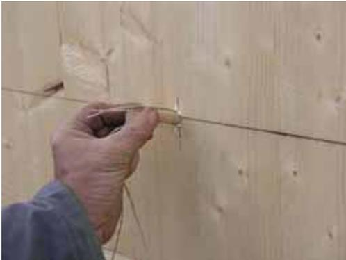
Holzdübel werden mit lösungsmittel- und formaldehydfreiem Klebstoff in den KLH-Massivholzplatten fixiert, welche wiederum Hanfschnüre verankern.
