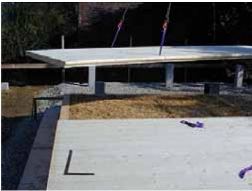
Mittels Kranwagen werden die großdimensionalen Bodenplatten auf die Unterkonstruktion aufgesetzt.
