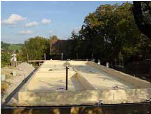
Auf kellerfreiem Fundament sind die Bodenelemente an die Oberkonstruktion angepasst.
