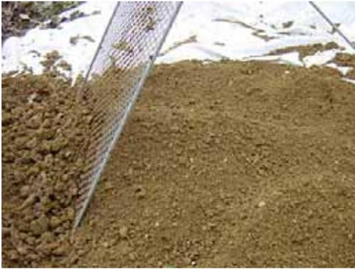
Mittels Sieb werden grobe Steineinschlüsse vom Aushubmaterial getrennt.
