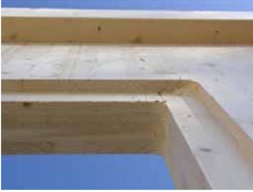
Spezielle Sonderkonstruktionen wurden für passivhaustaugliche Wandöffnungen vorgefertigt.
