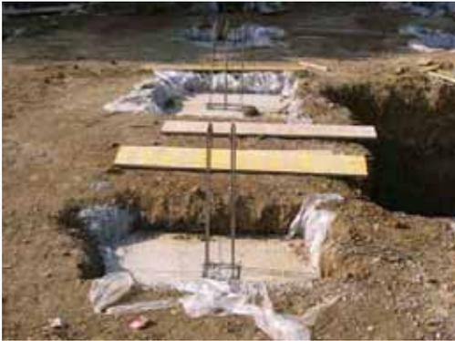
Die Hohlräume für die Punktfundamente wurden nach dem Ausheben mit Folien ausgekleidet, um ein späteres Entfernen der Fundamente zu erleichtern
