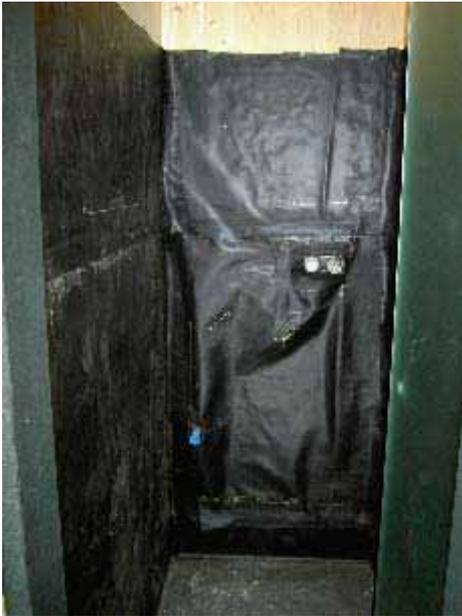
Die Duschräume wurden zunächst mit einer Kautschuk Folie abgedichtet und danach mit einer Abdeckung versehen. Beide Materialien sind wasserbeständig.
