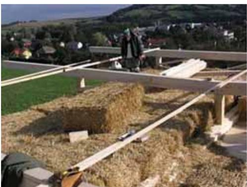
Die wärmebrückenfreie Strohdämmung muss dicht und ohne Hohlräume verlegt werden.
