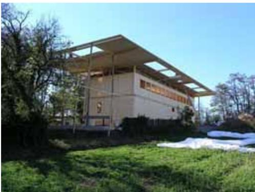
Der Dachaufbau mit wärmegeämmter Decke und abgesetztem Dach ist gut ersichtlich.
