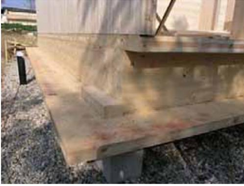
Luftdichte Anschlüsse zwischen Boden und Wandelementen sind ein essentieller Bestandteil.
