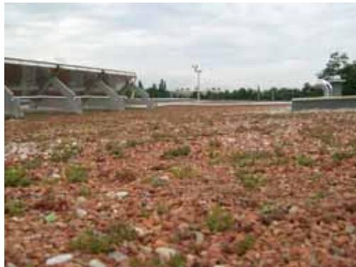
Die erste Vegetation breitet sich aus. Das Dach ist zur Mitte von beiden Seiten leicht geneigt, dadurch kann überflüssiges Wasser ablaufen. Zum Teil wird das Wasser gespeichert und zum Teil einem Sickerschacht zugeführt.
