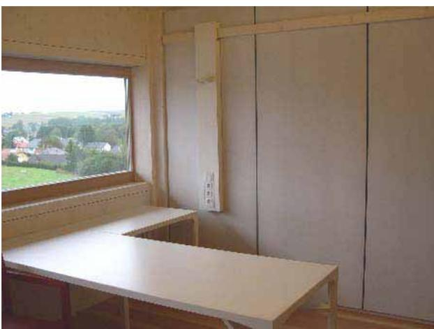
Die Kabeltrassen aus Holz befinden sich neben dem Licht- und Stromversorgungsmodul die gleichzeitig als Aufhängung für die Regale dienen. In den Gängen sind die Trassen gleich neben den Lüftungsrohren bzw. unter den Leuchtkörpern fixiert.
