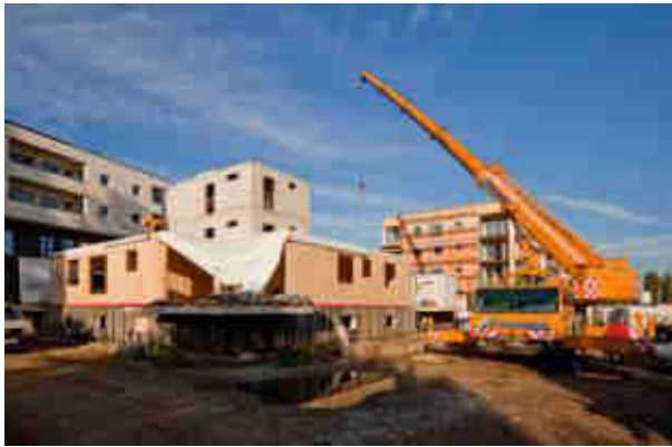
Abbildung 62 Baustelle +ERS: Montage der Holzbauteile bei einem Punkthaus. Quelle: Martin Grabner
