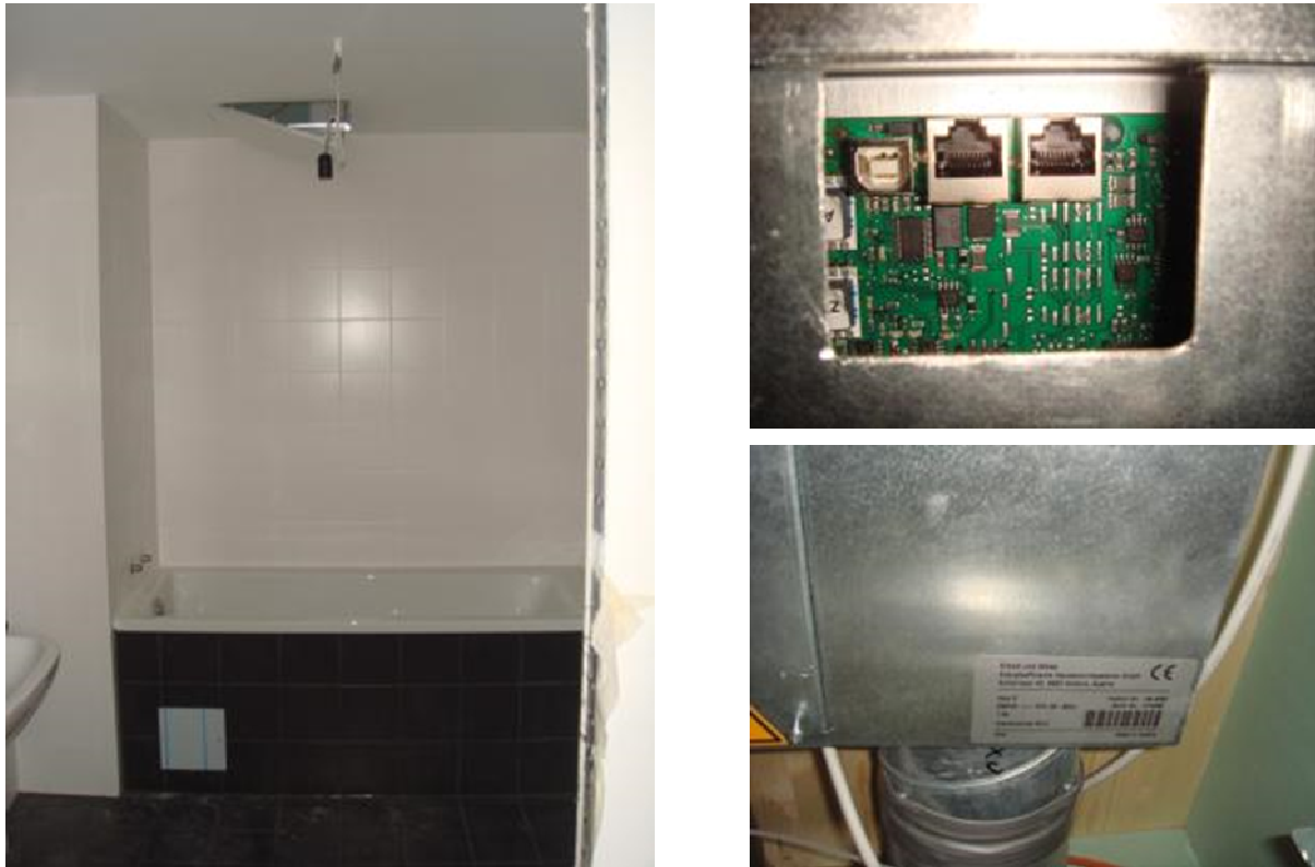
Abbildung 54 Baustelle +ERS: v-Box in Badezimmer einer Wohnung. Quelle: AEE INTEC
