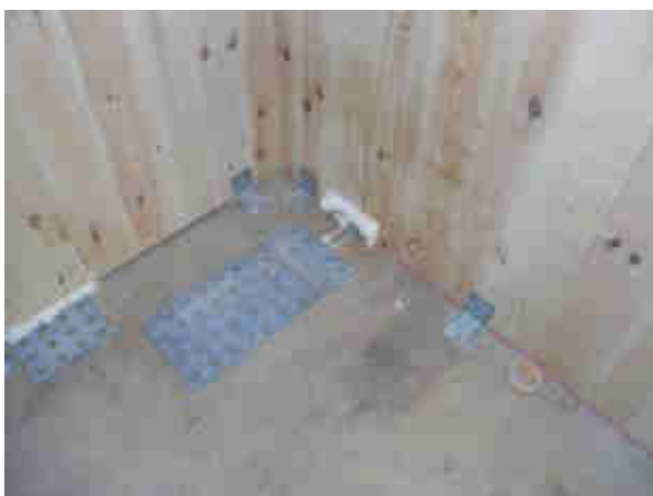
Abbildung 48 Blowerdoor Messung Haus E 12.04.2013. Leckagepunkte im Bereich der Befestigungswinkel und der horizontalen Sylomerlager. Quelle: AEE INTEC
