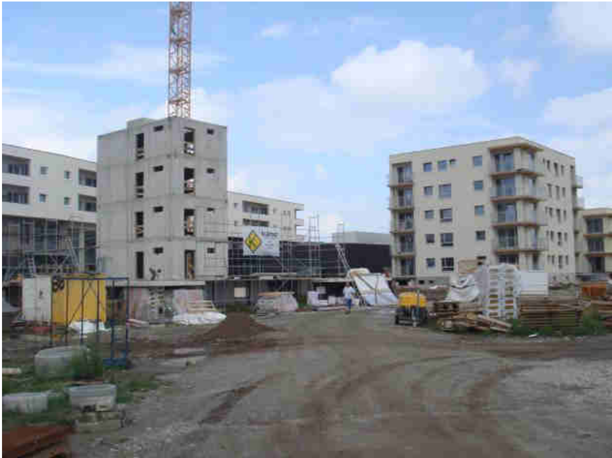
Abbildung 60 Baustelle +ERS: Im Hintergrund Bauabschnitt 1. Vordergrund Haus E und F Quelle. AEE INTEC
