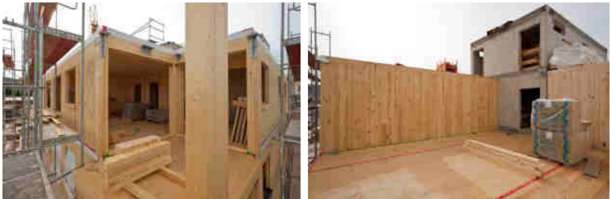
Abbildung 61 Baustelle +ERS: Montage der Holzbauteile bei einem Punkthaus. Quelle: Martin Grabner
