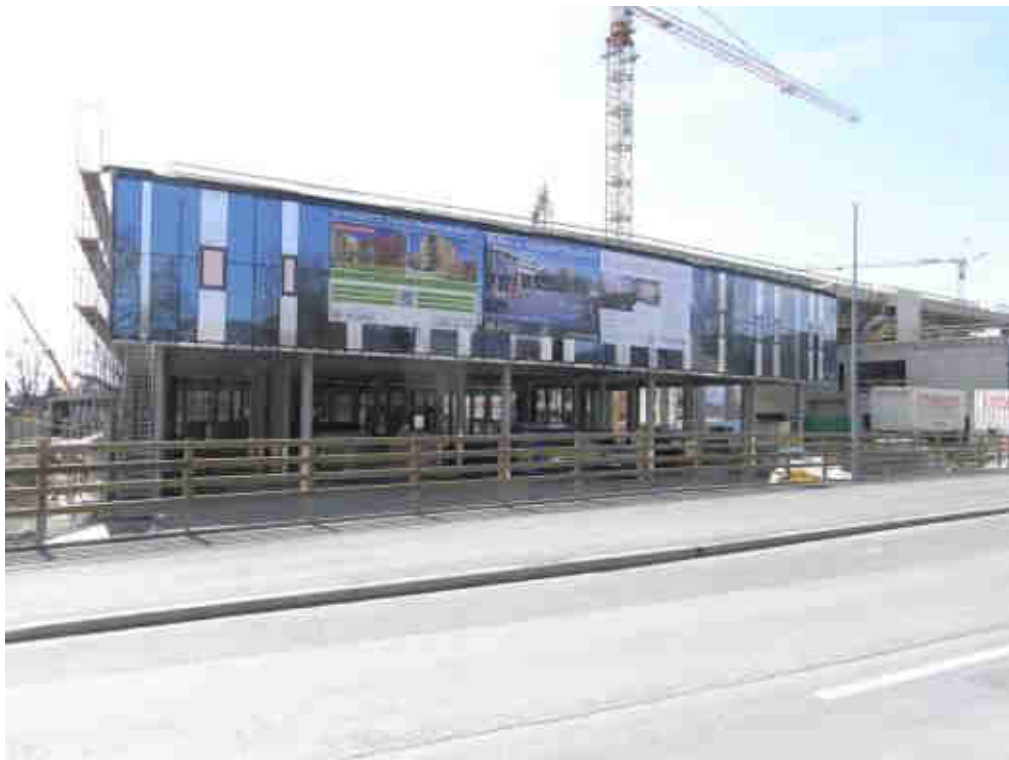
Abbildung 57 Baustelle +ERS. Bauteil 1, Büro und Gewerbe. Quelle: AEE INTEC
