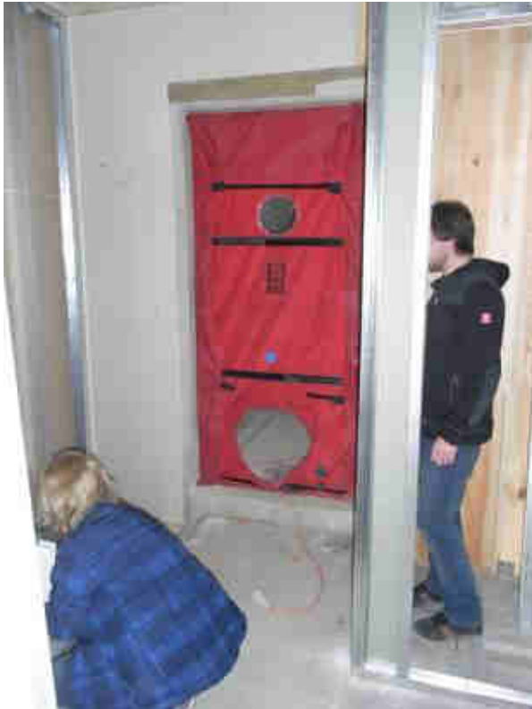
Abbildung 47 Blowerdoor Messung Haus E 12.04.2013. Einbau der Messanordnung. Quelle: AEE INTEC
