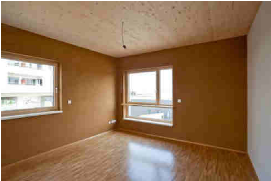
Abbildung 55 Baustelle +ERS: Außenwand Lehmbauplatte + Lehmputz. Quelle. AEE INTEC
