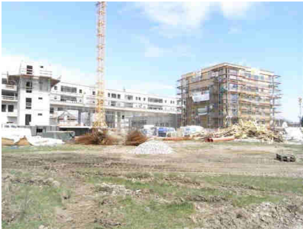
Abbildung 56 Baustelle +ERS. Hinten Bauabschnitt 1, vorne Bauabschnitt 2: rechts Haus E, links Stiegenhauskern Haus F. Quelle: AEE INTEC
