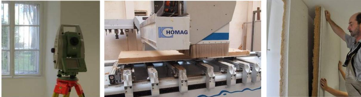
Abb. 12: Ablauf Sanierung in drei Schritten. Vermessung, CNC-Zuschnitt, Anbringung.
